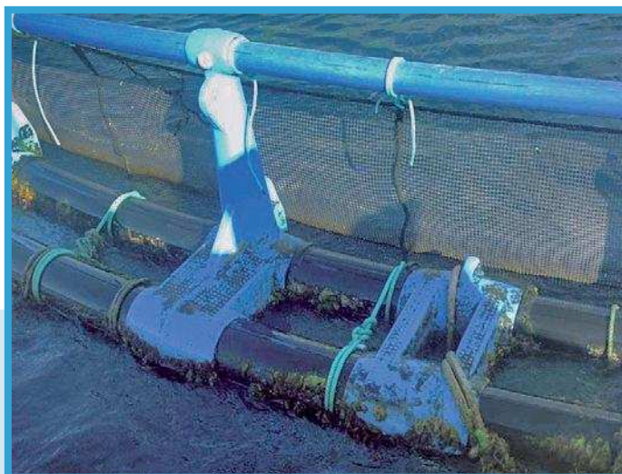
FIGURA 3.4. Estructura de flotación y sustentación.
