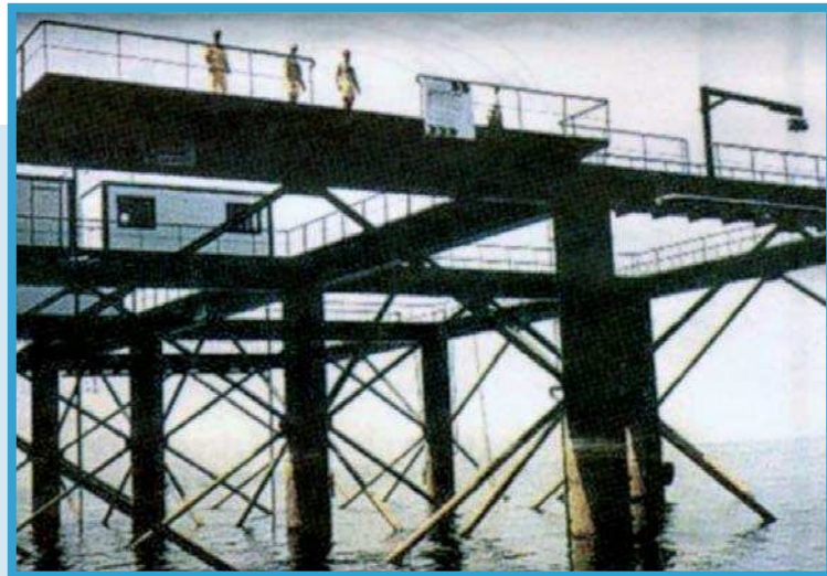
FIGURA 5.6. Plataforma de «Marina System Iberica».
