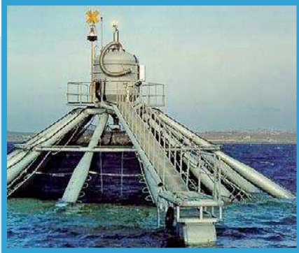
FIGURA 9.13. Estructura superior flotando. Vivero Farmocean.
