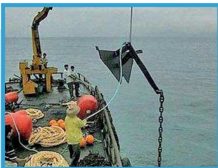
FIGURA 18.6. Instalación del fondeo (Global Aquafish).
