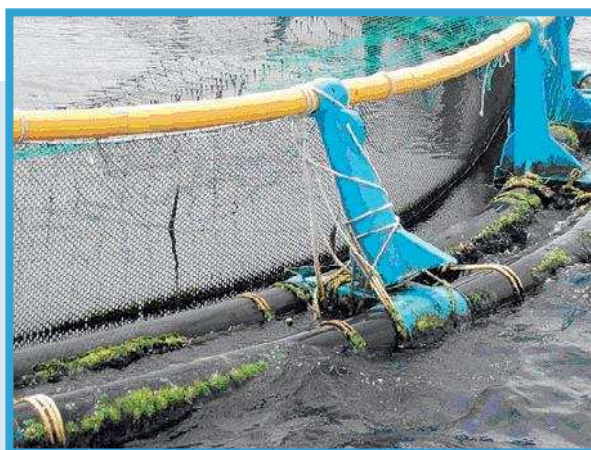
FIGURA 14.4. Daños en soporte (Global Aquafish).
