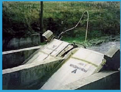
FIGURA 3.13. Filtro de banda.
