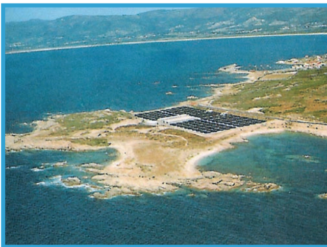
FIGURA 3.2. Instalación de Lira – Carnota.
