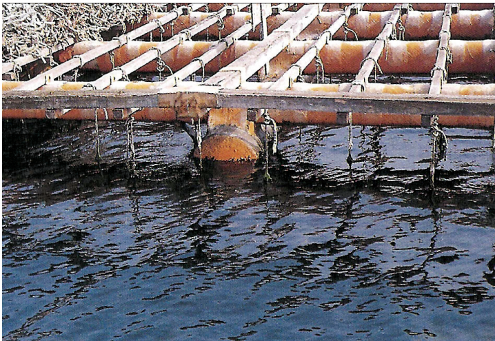
Figura 1.7. Batea con flotadores de tubos horizontales.
