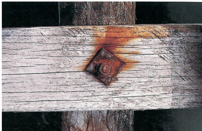
Figura 4.6. Unión de las vigas de través sobre las maestras (Figueiro y Cuña).
