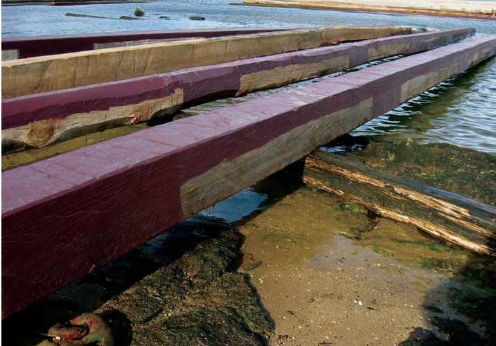
Figura 6.1. Pintado de vigas con patente (GA).
