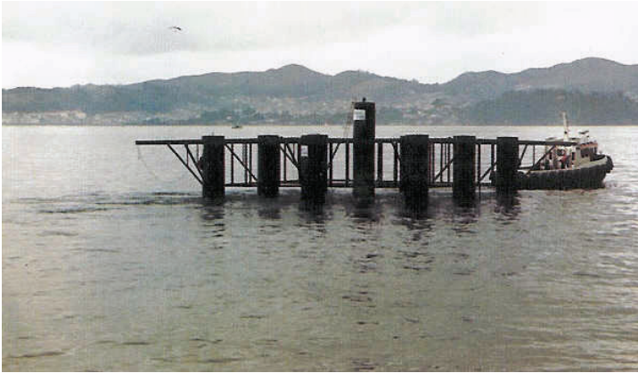
Figura 1.6. Batea con flotadores verticales.
